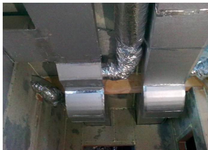
Внешний вид магистральных воздуховодов изготовленных из материала PirAlu
